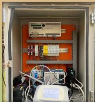
نصب تجهیزات حفاظت الکتریکی ( سرچ ارستر ) ایستگاه شهرستانک
