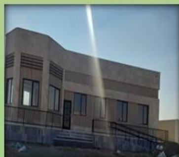
پیشرفت فیزیکی ۹۰ درصدی ساختمان ایستگاه هواشناسی اشتهارد
