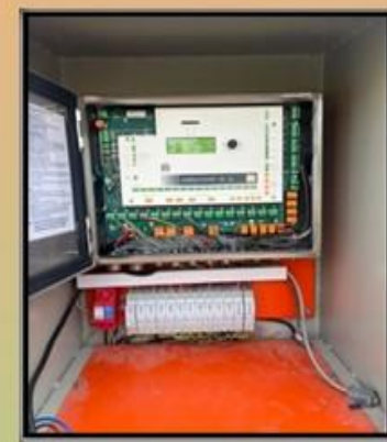
نصب تجهیزات حفاظت الکتریکی ( سرچ ارستر ) برای تمامی سنسورها و برق ورودی و تعویض باتری ایستگاه مشکین دشت
